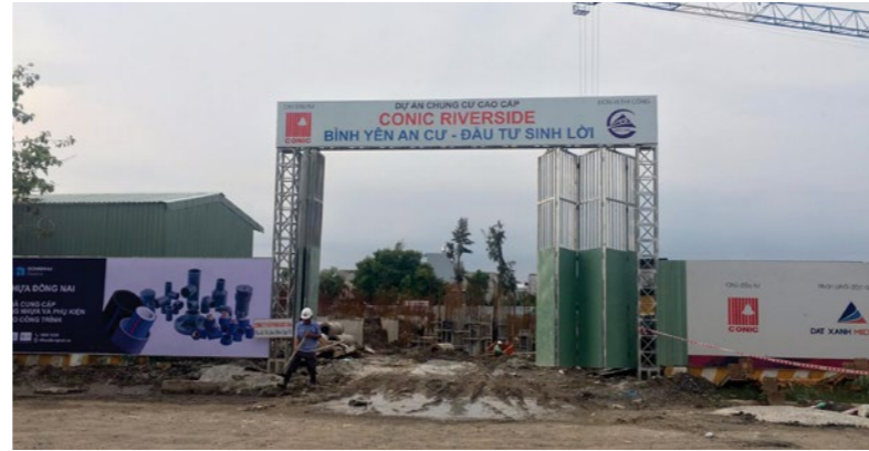
Dự án Conic Riverside 2 khối căn hộ 22 tầng
