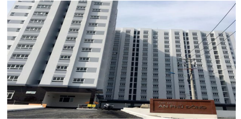
Dự án Chung cư An Phú Đông Khối căn hộ 16 tầng
