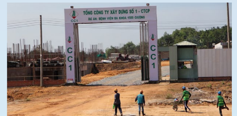
Dự án Bệnh viện đa khoa Bình Dương Bệnh viện 1500 giường
